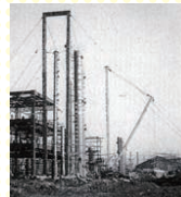
建設中の第1酸化エチレン・エチレングリコールプラント (1959年)
